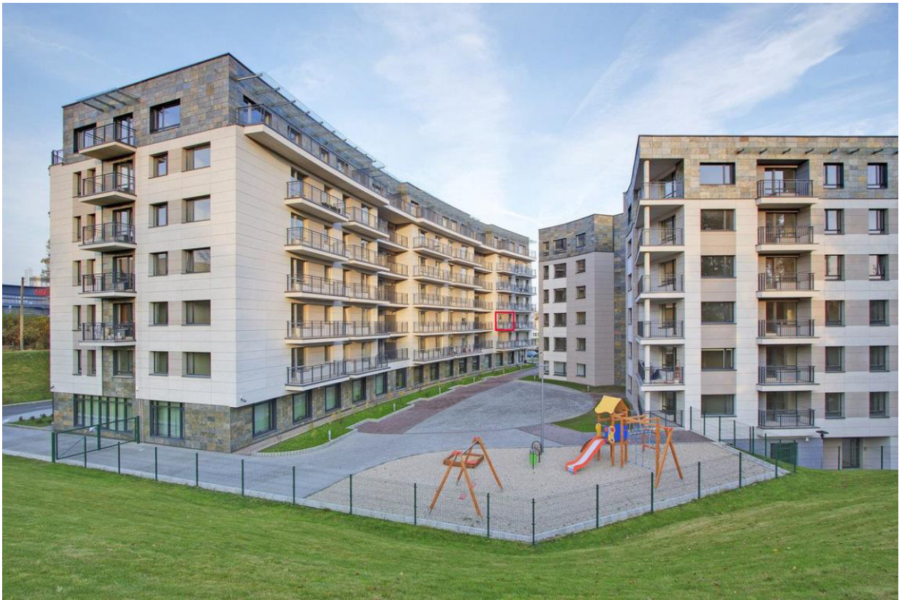
Projektuojamų patalpų Nr. 113 vieta esamo pastato pietiniame fasade
