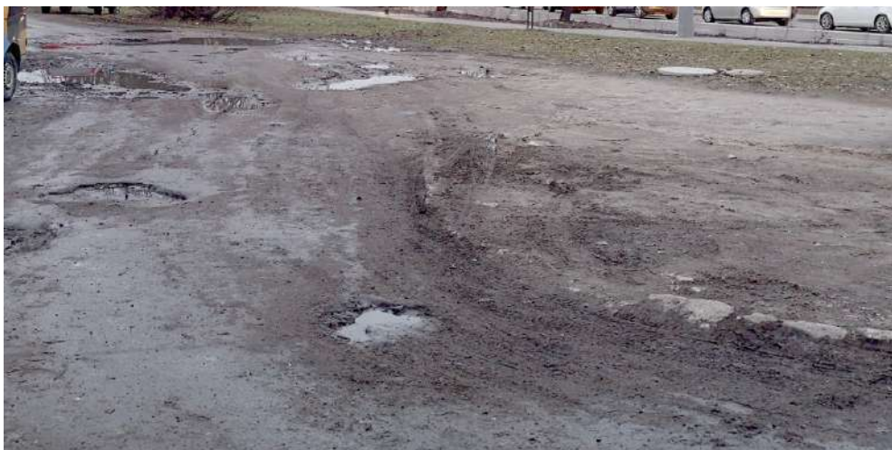
Asfalto dangos pravažiavimas
