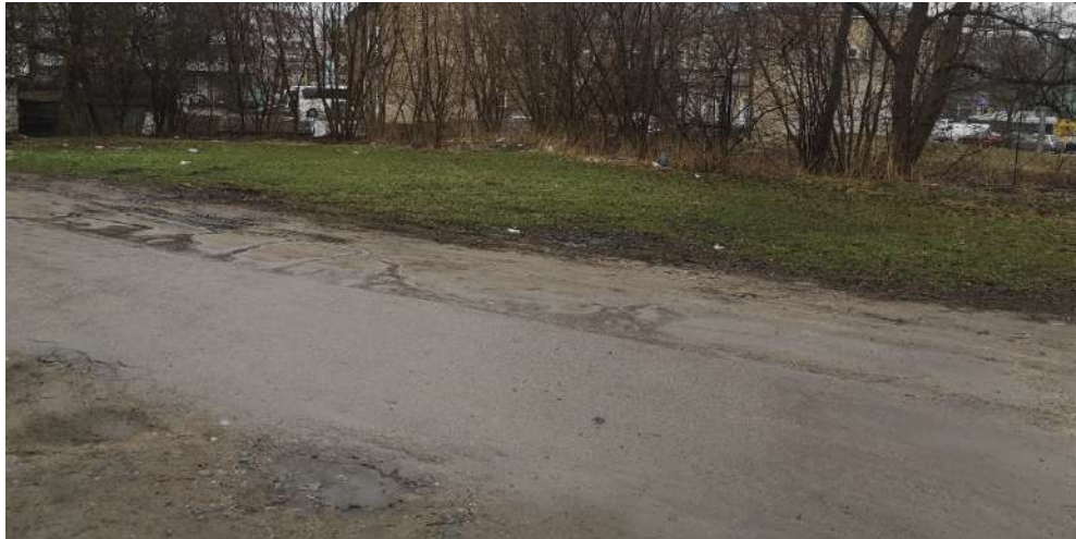
Asfalto dangos pravažiavimas
