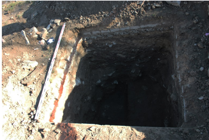
Fotografija Nr. 5. Šurfo Nr. 2 bendras situacinis vaizdas ŠV šurfo dalyje pasiekus betoninę (šiluminės trasos) dangą
