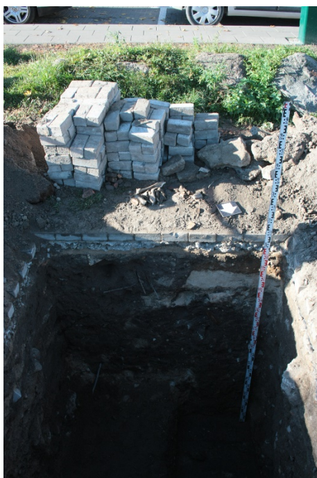
Fotografija Nr. 6. Šurfo Nr. 2 PR sienelė pasiekus betoninę (šiluminės trasos) dangą
