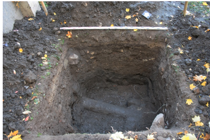
Fotografija Nr. 19. Šurfo Nr. 4 bendras situacinis vaizdas pasiekus nuotekų vamzdį ir pradėjus sunktis vandeniui
