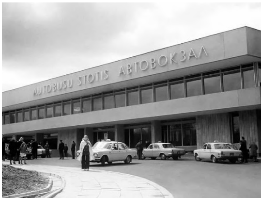
17 pav. Sodų g. 22 – pagrindinis fasadas 1980 m.
