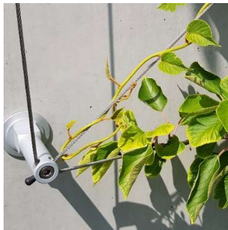
Kairėje – laipiojančioji hortenzija. Dešinėje – trosų sistemos tvirtinimo detalės
