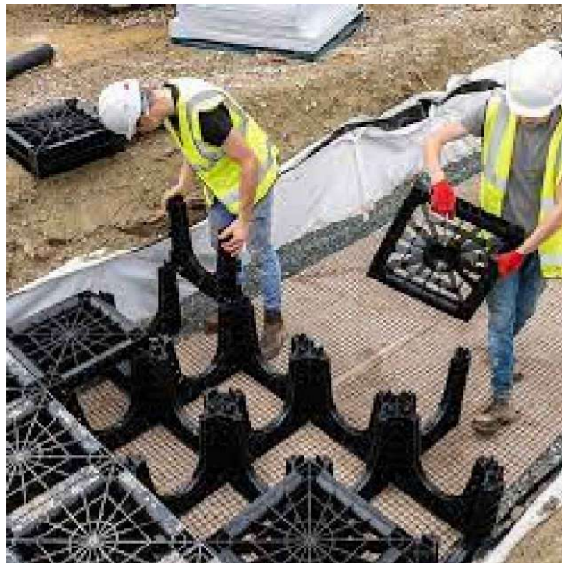
NAUJAI SODINAMŲ MEDŽIŲ ŠAKNŲ APSAUGA GREENBLUE "ROOTSPACE"
