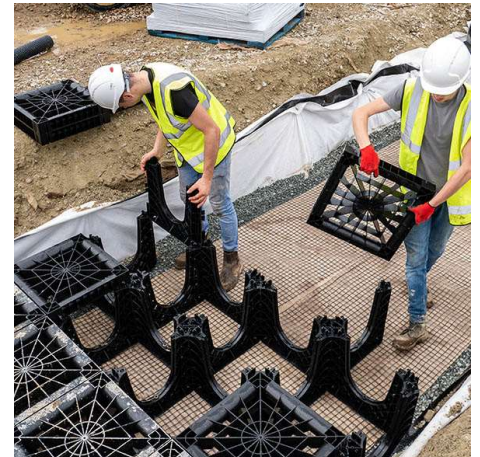
Šaknų apsauginė / irigacinė sistema BLUEGREEN URBAN "RootSpace"
