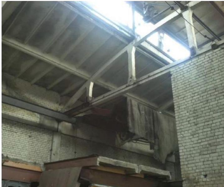
Rekonstruojamos pastato dalies vidaus fragmentas
