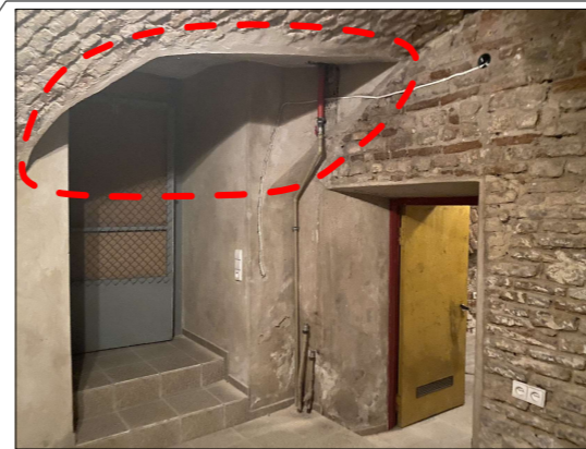
Užbetonuotas mūrinės skliautinės perdangos fragmentas
