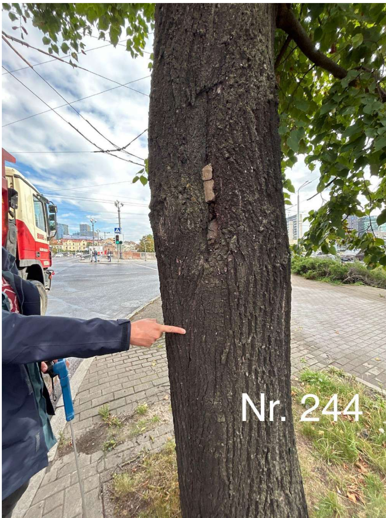
Mažalapė liepa (nr. 244 plane) - kamiene matomas trūkis. Rekomenduojama atlikti lajos priežiūros genėjimą ir augavietės gerinimo (revitalizacijos) procedūras. Atlikinėti nuolatinį būklės monitoringą dėl kamieno trūkio.
