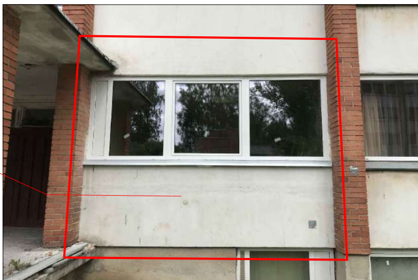
Patalpos kontūras pažymėtas fasade
