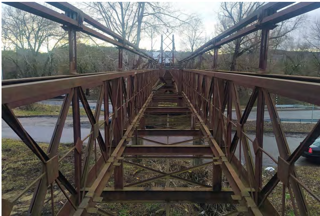
3 pav. Tilto viršaus vaizdas (Elektrinės g. pusėje)
