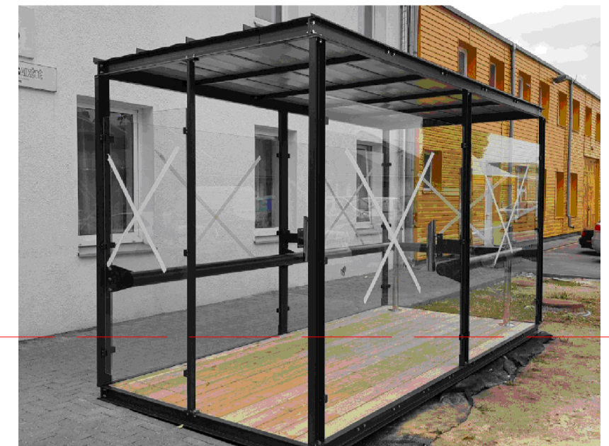
Silpnas rikiomis paviljono vieta - Paviljono lengva surenkama konstrukcija, kurios nerikiama pamato, stiliui paviljono matmenys - 4,5x2,5m, o medžiagumas - karkas - lizvinis profiliai orkuogami ir dažomi miltelinu būdu, sienos - 10mm skaidrus grūdintas stiklas, grindys - terasinis lentos, stogas - skarda.
