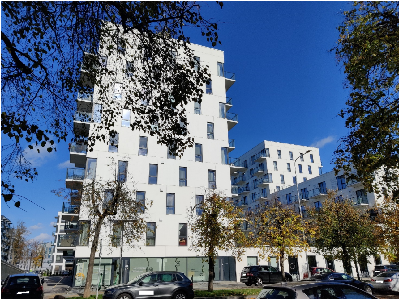
3 pav. Pastato fasadas.
