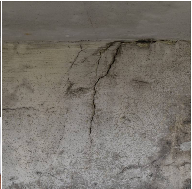
17 pav. Normaliniai plyšiai laiptasijoje.
