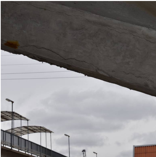
16 pav. Išilginiai plyšiai laiptasijoje.
