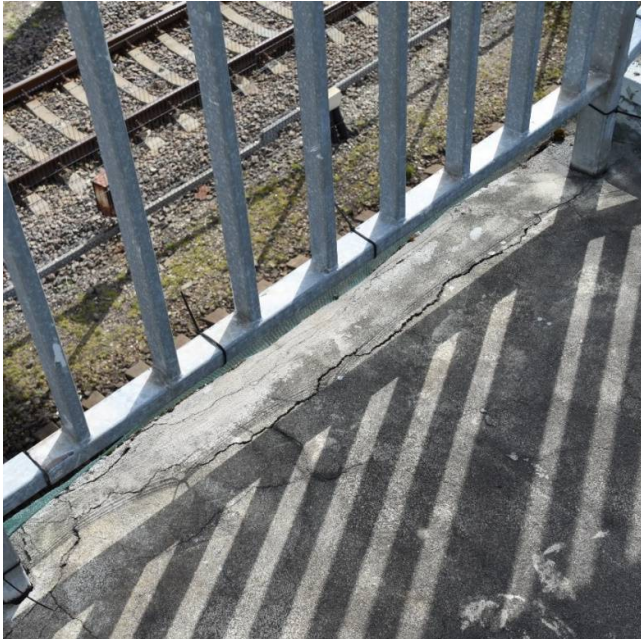
22 pav. Išilginiai plyšiai tarpinės aikštelės kraštuose.
