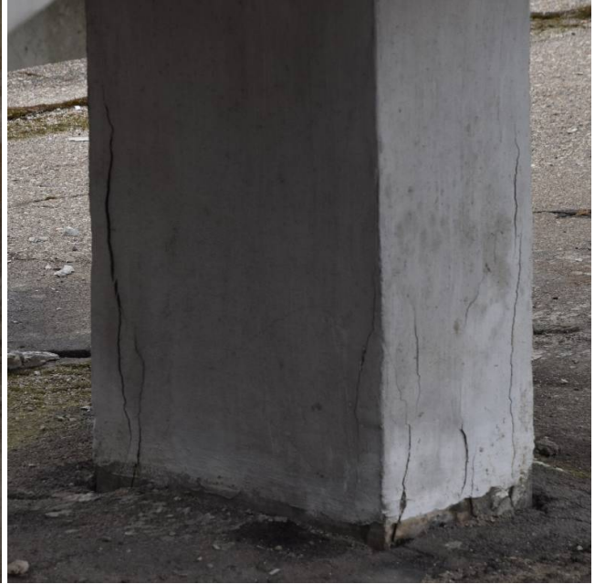
15 pav. Išilginiai plyšiai kolonos apatinėje dalyje.
