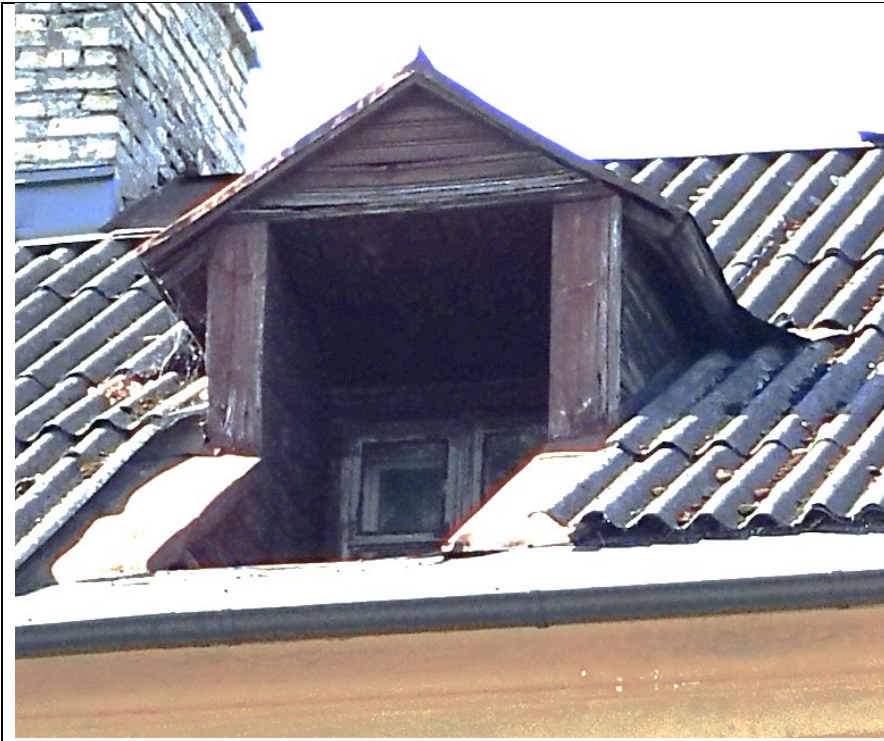
Esamų tūrinių stoglangių fotofiksacijos iš Švenčionių gatvės.
