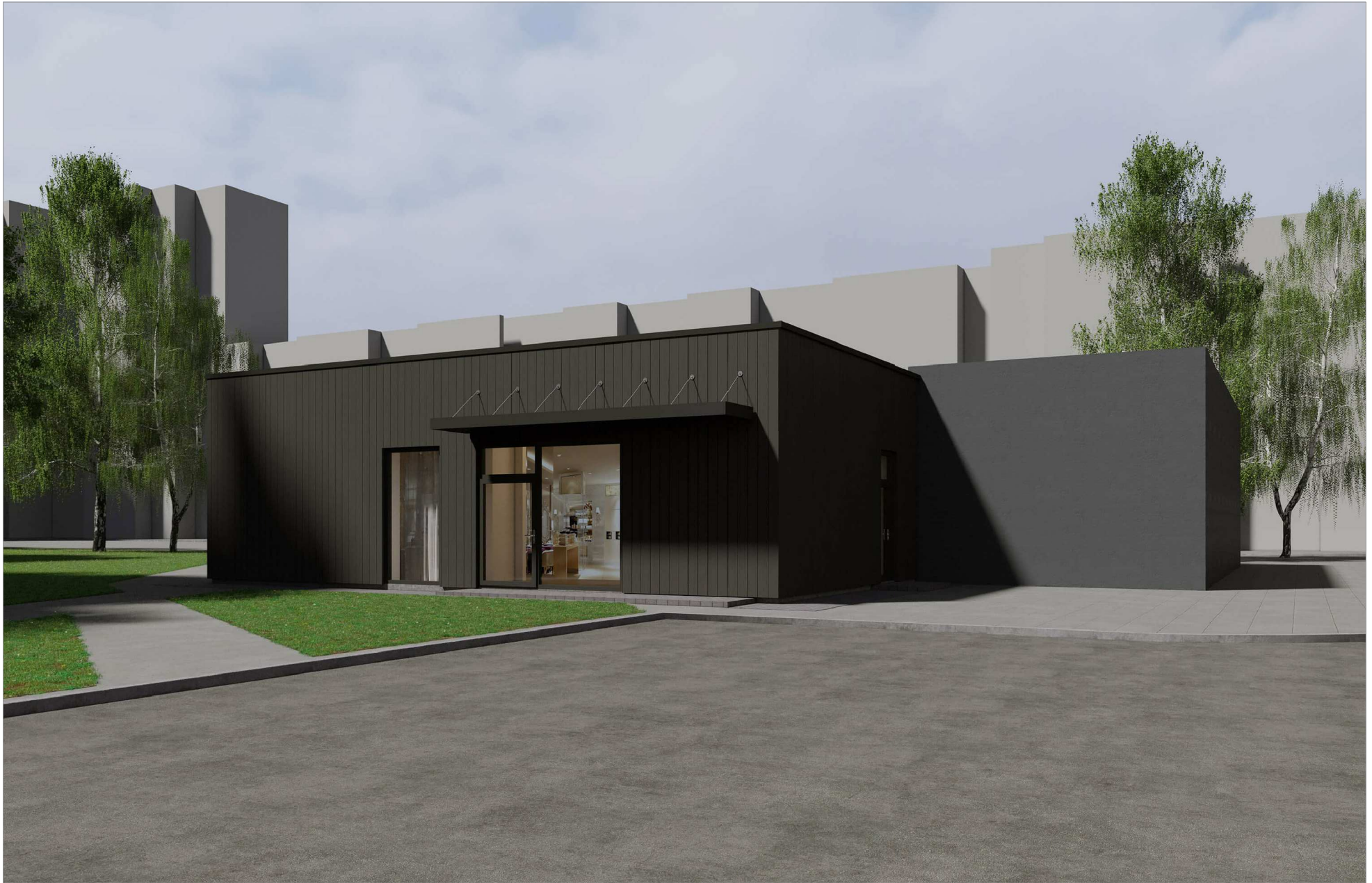
Vakarinis fasadas (iš gatvės)
