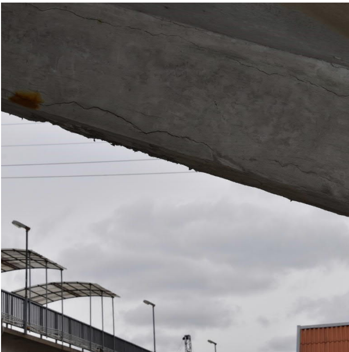
16 pav. Išilginiai plyšiai laiptasijoje.
