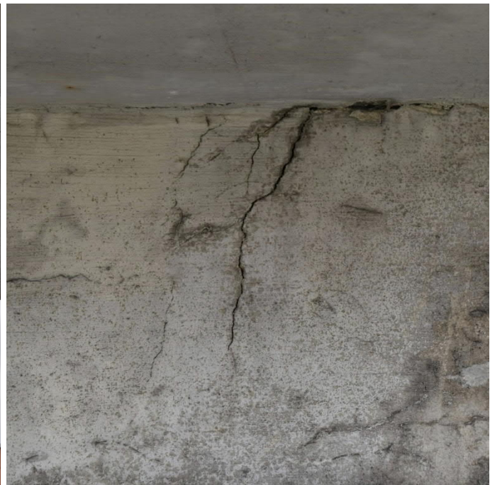
17 pav. Normaliniai plyšiai laiptasijoje.
