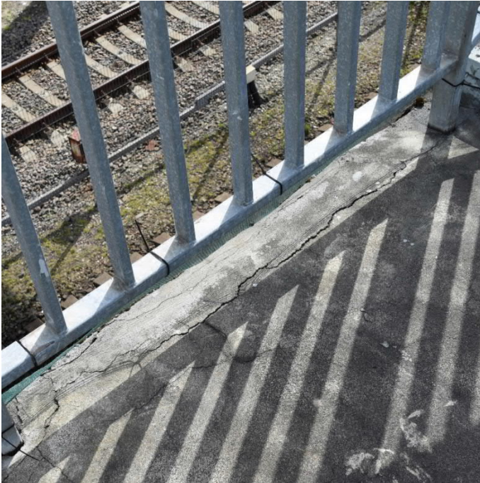
22 pav. Išilginiai plyšiai tarpinės aikštelės kraštuose.
