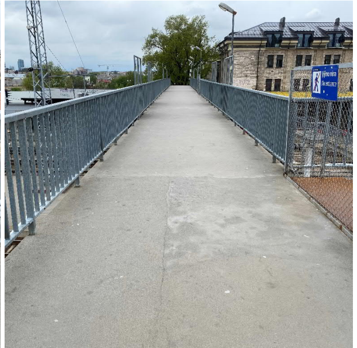
3 pav. Einamosios dalies dangos būklė gera (vaizdas nuo tilto vidurio link 1-ojo perono)
