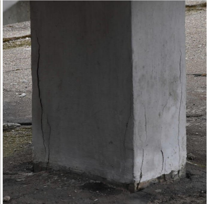
15 pav. Išilginiai plyšiai kolonos apatinėje dalyje.
