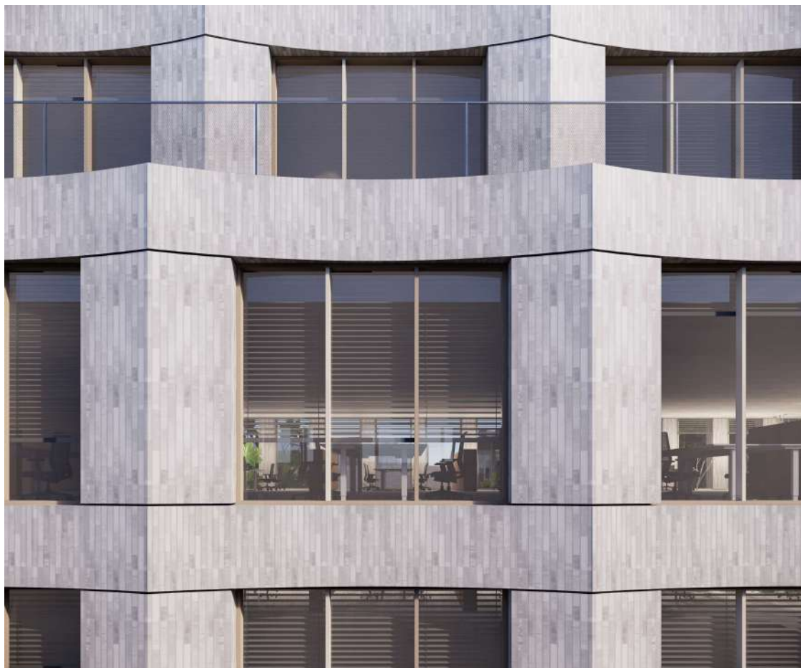
Pav. 21_B2 korpuso fasado apdaila – šilto pilko atspalvio klinkerio apdaila. Sprendinys tikslinamas techninio projekto rengimo metu
