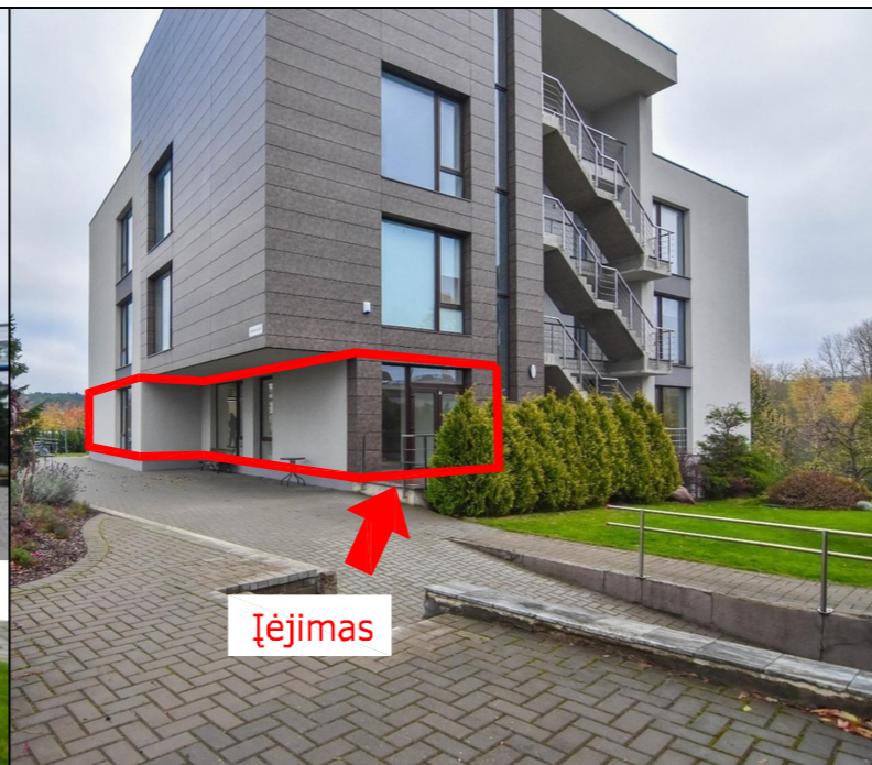
Fotofiksacijos su pažymėta patalpos vieta
