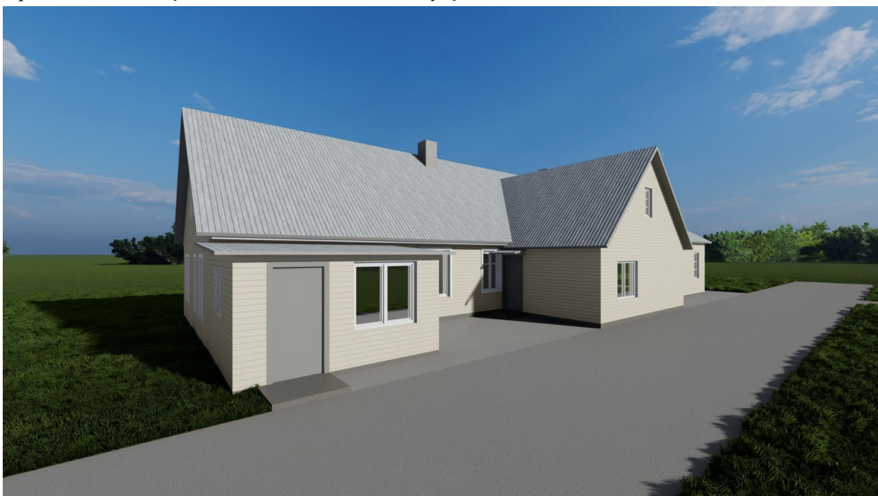
7 pav. Pastato fasadų E-A ir 1-7 vaizdas iš šiaurės-rytų.
