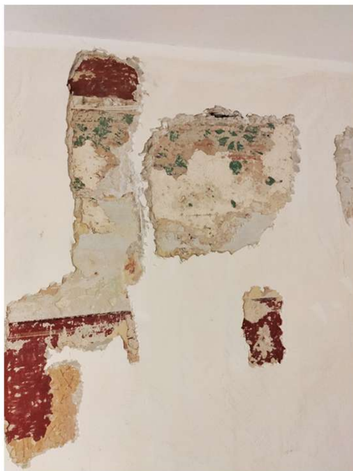
Fot. 12 Patalpa Nr. 3-6 Atodangos ant V sienos
