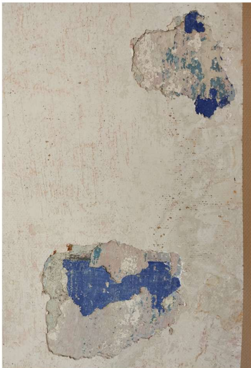
Fot. 20 Patalpa Nr. 3-11 7 sl. apvadinės juostos fragmentai
