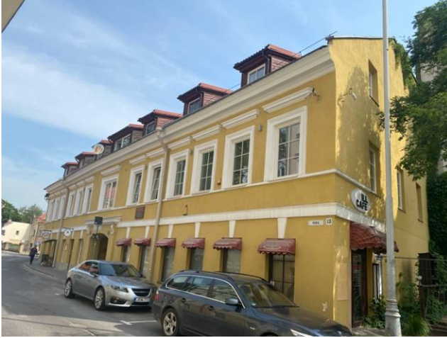
Tiltos g. 13 gatvės fasadas
