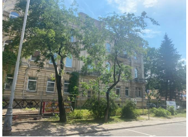
Tiltos g. 11 gatvės fasadas
