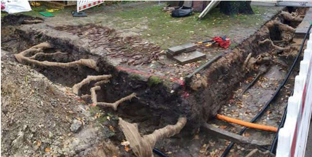
3 pav. Tranšėjos ir gatvės konstrukcijos lovio kasimo išsaugant medžių šaknis pavyzdys
