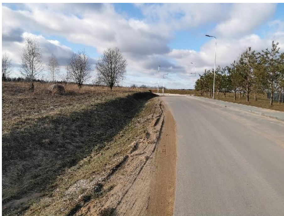
5 pav. Pagal projekto 0 laidą įrengta Daujoto gatvė
