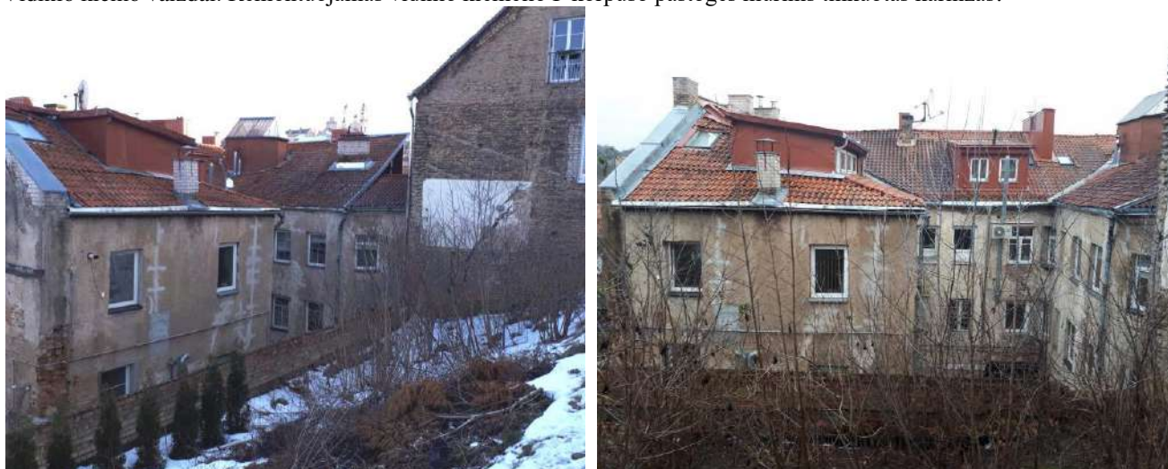
Vidinio kiemo vaizdai iš Bokšto g. 10 kiemo. Kaminai apskardinti, primūryti silkatinėmis plytomis. Kiemo fasade įrengti tūriniai stoglangiai
