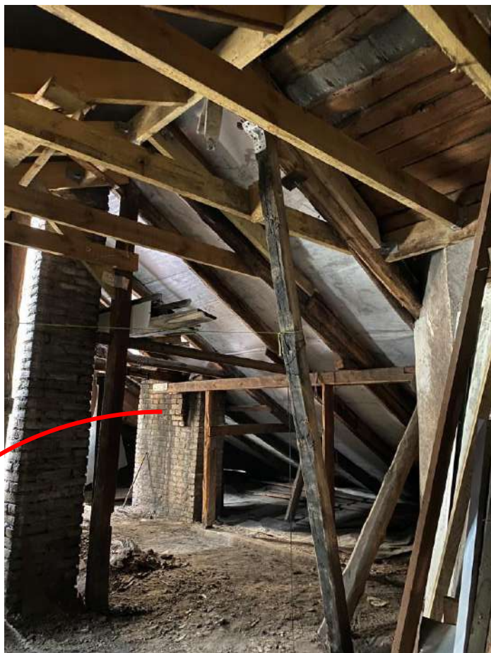
Pav. 9 Ašies "C" tarp 2-3 vaizdas. Antrinio panaudojimo mediena.
