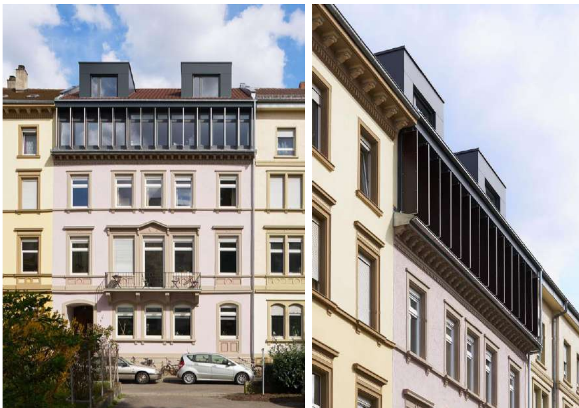
ISTORINIO DAUGIABUČIO GYVENAMOJO NAMO MIESTO CENTRE IŠPLĖTIMAS, ĮRENGIANT BUTĄ, Karlsruhe, Vokietija. Architektai: Archittoo, Angelina Schneider Šaltinis: https://www.archittoo.de/bauen-im-bestand/cvjm-nowackanlage-5/
