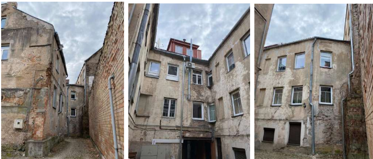
Vidinio kiemo vaizdai. Remontuojamas vidinio kiemelio P korpuso pastogės mūrinis tinkuotas karnizas.
