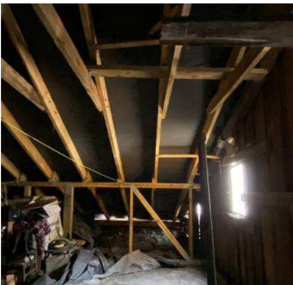
Pav. 7 Tarp ašių 3-4 naudotos naujų konstrukcijų medienos vaizdas.
