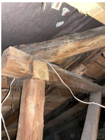
Pav. 10 Po gaisro, keičiant konstrukcijų schemą, išpjauti ilginiai
