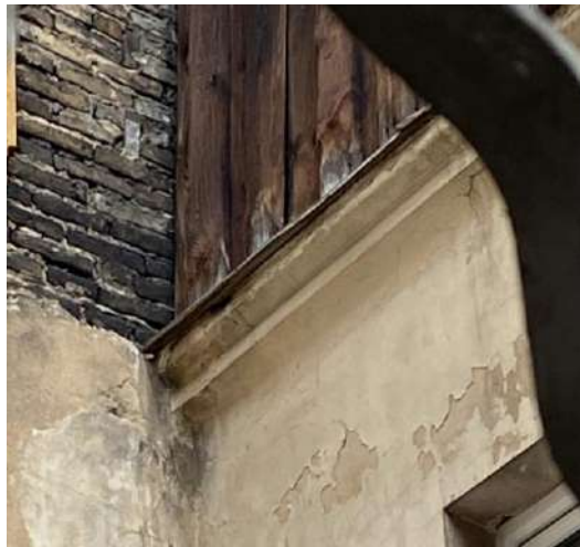
PV kiemelio karnizas po mediniu frontonu
