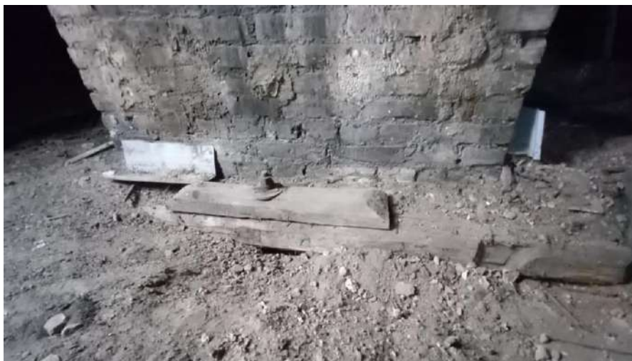
Pav.4 C ašies perdangos sijos galo iškabinimo prie kamino mazgas. Šį mazgą galima bus išsaugoti.
