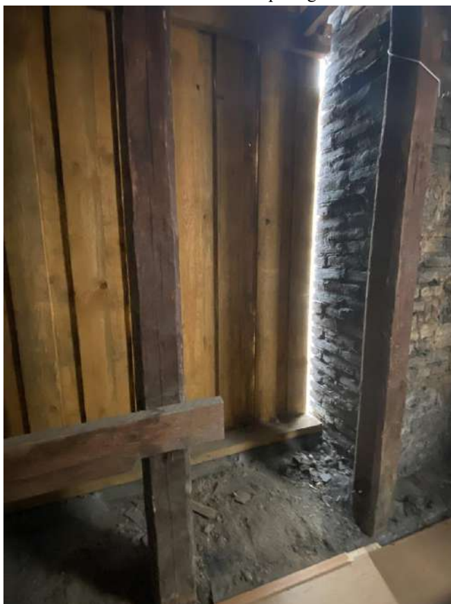
Pastogės fasadų medinė apkala iš vidaus.
