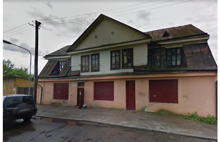
Pav 2. Paliekamas Priekalo g. 9 pastatas (šaltinis: "Google")
