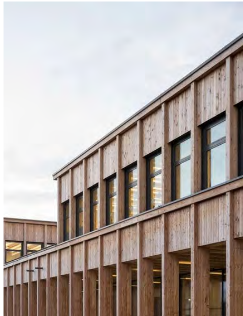
Korpusas C, naujas tūris Medienos lentos ir tašai, struktūrinė kompozicija
