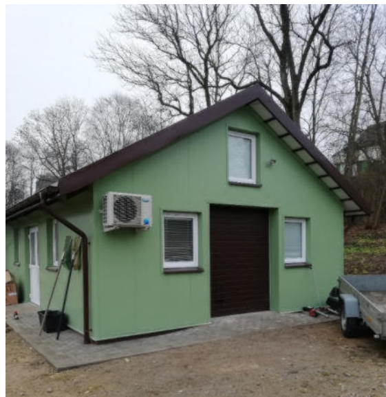
2 pav. Remontuojama stoginė
