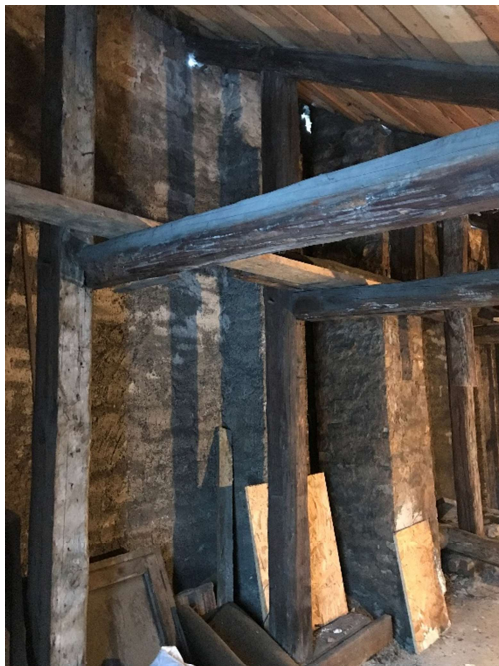
Ugniasienės ir palėpės konstrukcijų fragmentas. Fotofiksacija
