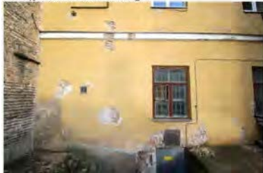
kiemo fasade buvusi durų anga ir balkono-lauko laiptinės žymės
