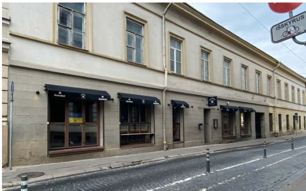
u/nr. 1094-0442-4015 gatvės fasadas
