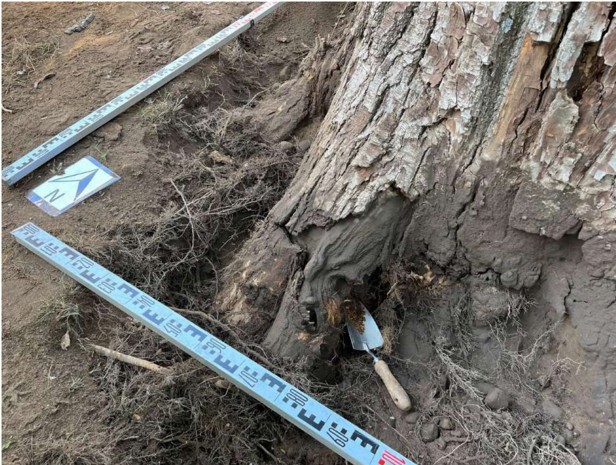
Pav. 4.2.2. Šaknų kaklelio revizijos metu kanadinės tuopos Nr. KT2 priekelminėje dalyje rastas puvinys
