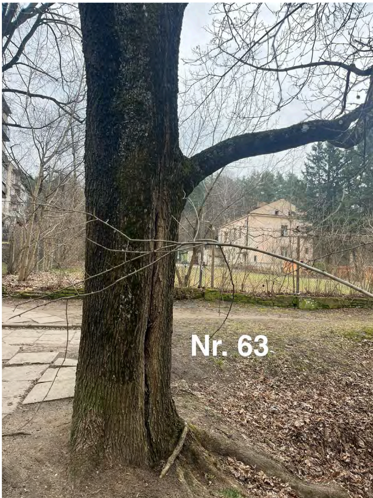
Paprastasis klevas (Nr. 63 plane) - Kamiene matomas trūkis, bei šaknų kaklelį smaugia šaknis. Rekomenduojama atlikti lajos priežiūros genėjimą bei kasmetinį būklės monitoringą dėl galimų pakitimų ateityje. Tinkamai pašalinti šaknų kaklelį smaugiančią šaknį.
