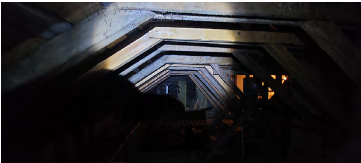
11 pav. Gegnių išdėstymas po sustiprinimo.
