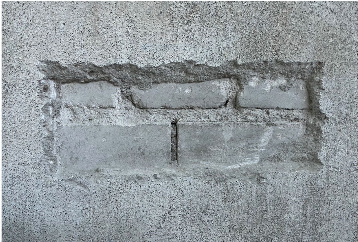
Pranciškonų g. 4A, Vilniuje, architektūriniai tyrimai. Vėlyvasis, XX a. antros pusės silikatinių plytų mūras. 2024-06
