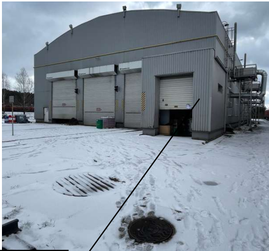
pav. Vakarinė pastato pusė
