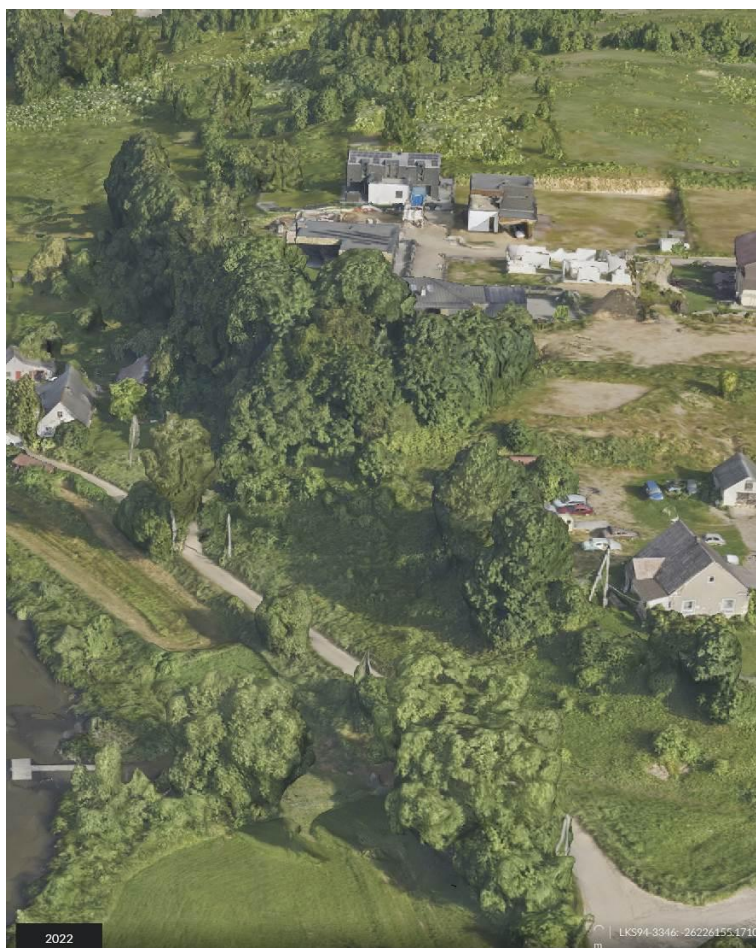
30. pav. Esama šlaito 3D situacija šiaurės kryptimi
