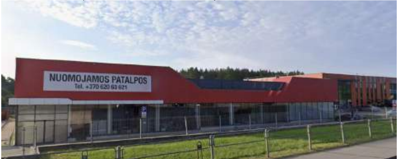
PAV. 2: Esamos situacijos fotofiksacija
