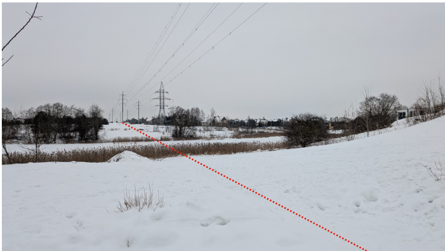
6 pav. Rekonstruojamos elektros linijos ruožas. Vaizdas iš PR. 2026-02-05
