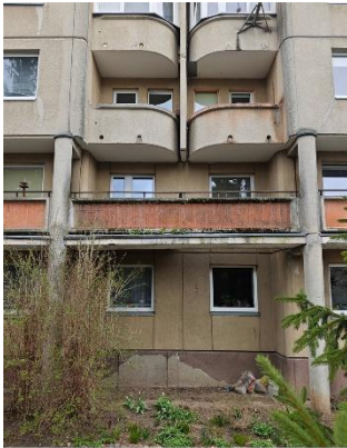
(5) užapvalinti balkonai (3-9 a.)
