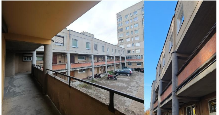
(3) atviros galerijos su kolonomis ir betoniniais turėklais-atitvaromis
