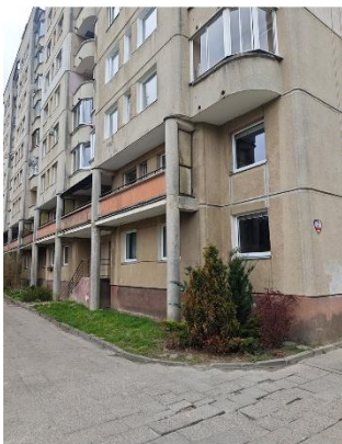
(9) įgilintos vidinio kiemo fasado dalys su kolonomis ir antrojo aukšto lodžijų atitvaromis
