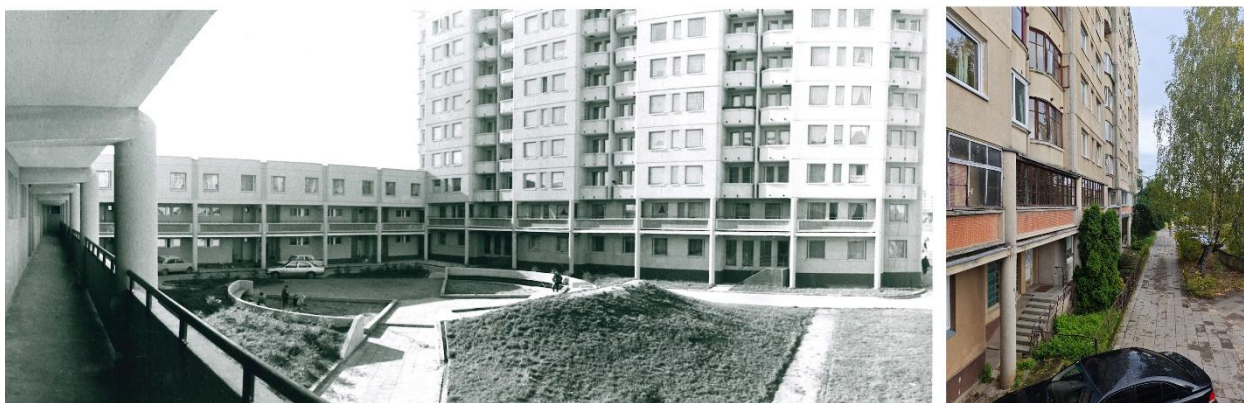
(9) įgilintos vidinio kiemo fasado dalys su kolonomis ir antrojo aukšto lodžijų atitvaromis
