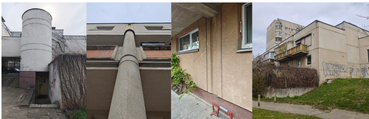
(9) išorinių sienų horizontalūs ir vertikalūs rustai bei įgilinimai/spaudai tarp butų sekcijų ir pagrindinių fasadų kraštuose
