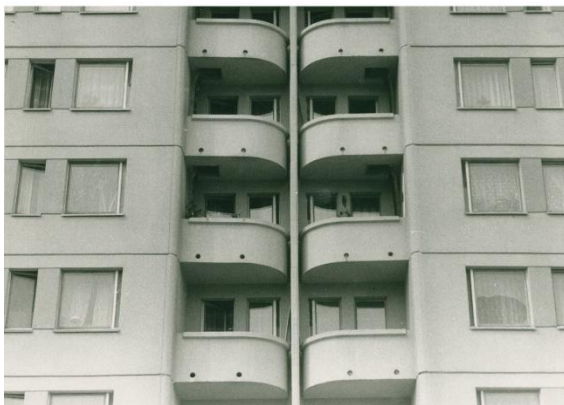
(5) užapvalinti balkonai (3-9 a.)
