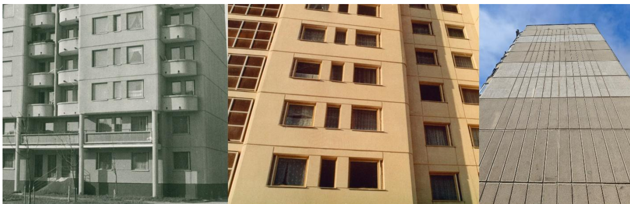
(8) vertikalūs ir horizontalūs išorinių sienų rustai
