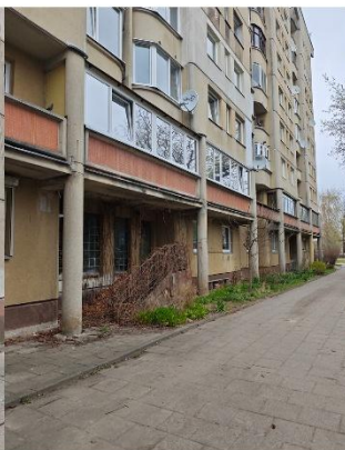
(9) įgilintos vidinio kiemo fasado dalys su kolonomis ir antrojo aukšto lodžijų atitvaromis
