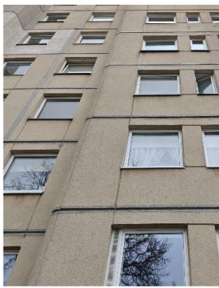
(8) vertikalūs ir horizontalūs išorinių sienų rustai
