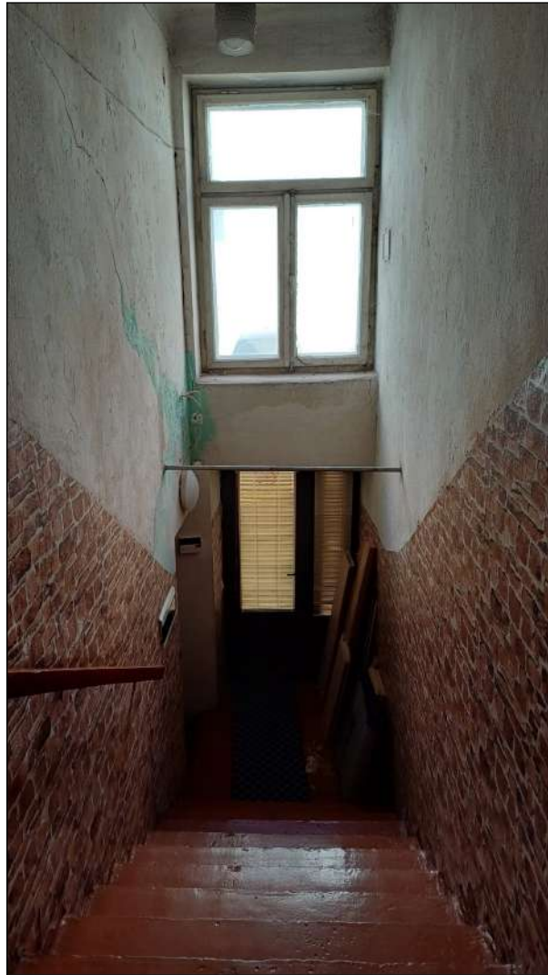
Esamų laiptų į pirmą aukštą fotografacija
