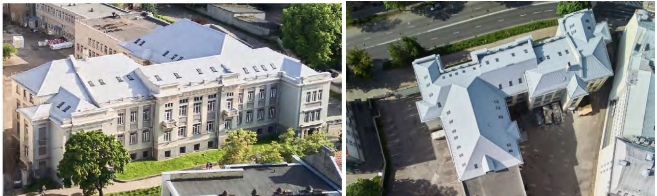
Fotofiksacijos iš stogo galimybių analizės. Esama stogo situacija.
