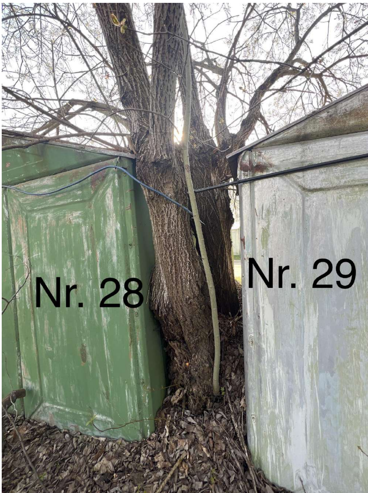
Blindės (nr. 28 ir nr. 29 plane) - auga tarp garažų, abiejų kamienai apauginę garažo stogo dalį. Siūloma šalinti.
