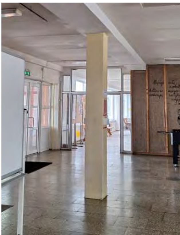
Pav 3. Kolonos 30x30cm surenkamo gelžbetonio, daugelyje vietų neuždaros, tinkuotos
