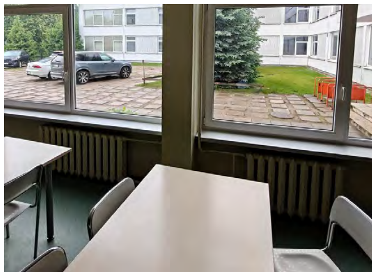
2 pav. Valgykloje įrengti ketiniai radiatoriai.
