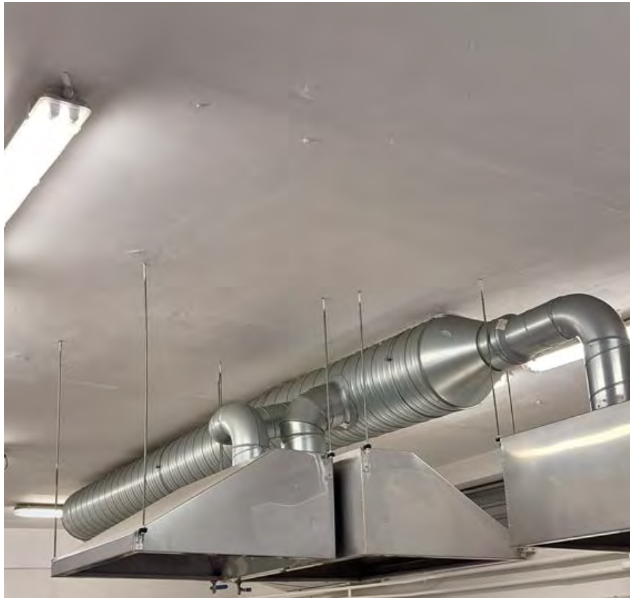
8 pav. Virtuvės oro ištraukimo sistema.
