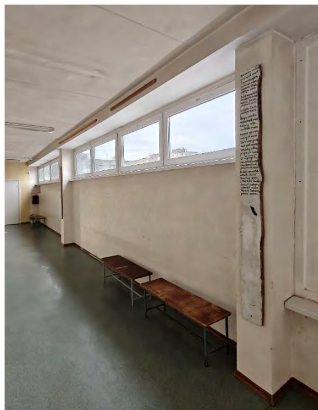
Pav 3. Kolonos 30x30cm surenkamo gelžbetonio, daugelyje vietų neuždaros, tinkuotos
