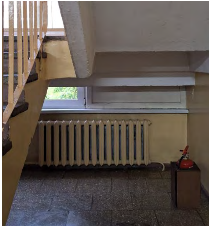
1 pav. Mokyklos laiptinės ketiniai radiatoriai.
