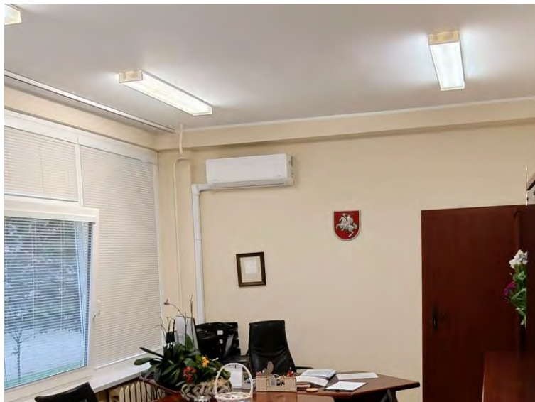
10 pav. Vidinis sieninis vėsinimo įrenginys.
