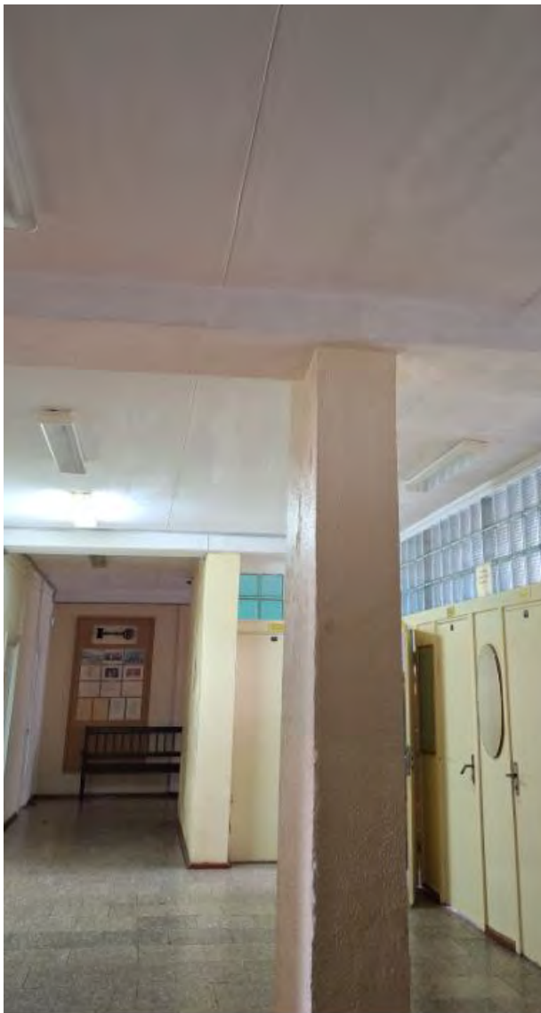
Pav 7. I aukšto koridoriaus perdanga prie rūbinės
