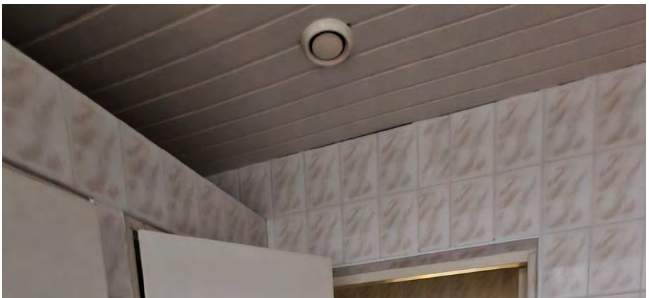
9 pav. oro ištraukimas iš tualetų.
