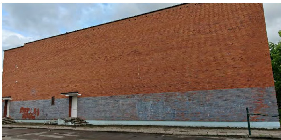
Pav 6. Raudonų plytų mūro sienos ~510mm storio
