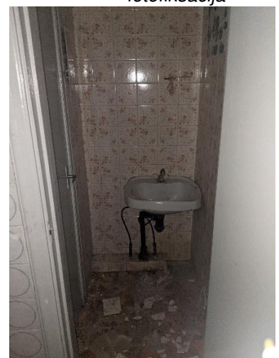
Pav. 9. Pirmo aukšto san. mazgo fotofiksacija
