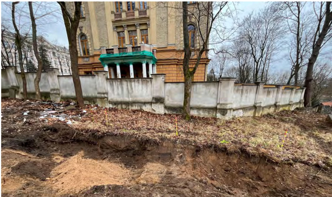
Pav. 4.2.4.Redukcinės tranšėjos įrengimas paprastiesiems klevams Nr. K22, K26, K30, K32, K34
