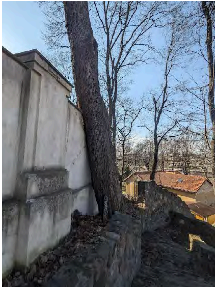
Pav. 4.4.2. Paprastojo klevo Nr. K19 augavietė vertinamoje teritorijoje smarkiai apribota atraminės sienos, kurios, siekiant nepažeisti šaknyno, negalima ardyti.
