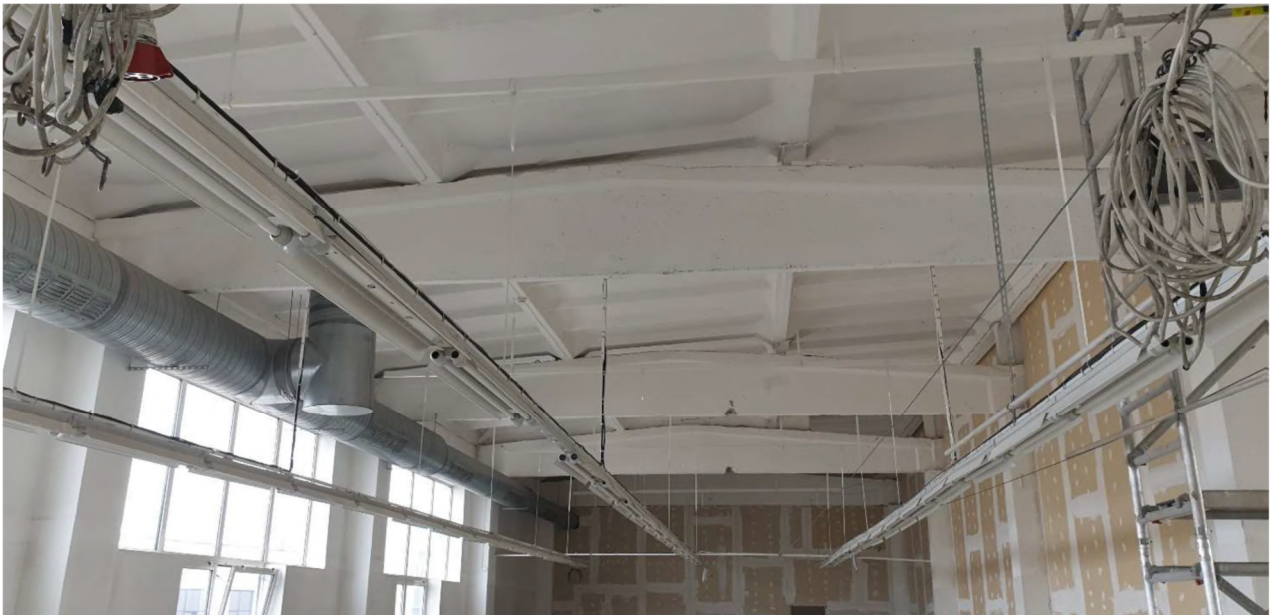
20 pav. Deginio konstrukcijų bendras vaizdas
