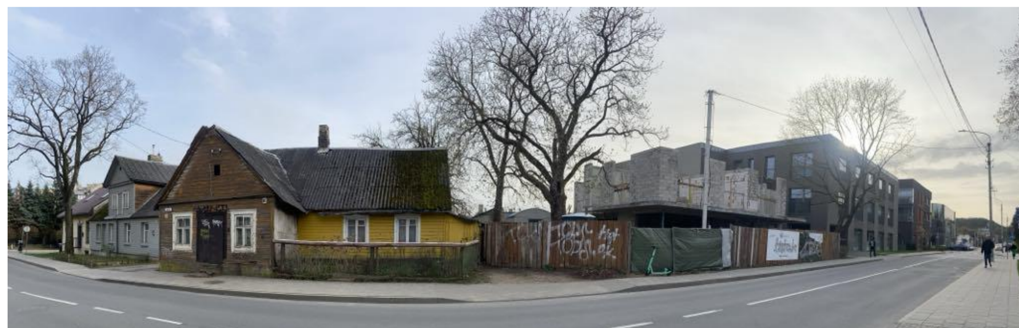
SĖLIŲ GATVĖS IŠKLOTINĖS FOTOFIKSACIJA. 2024 M.
