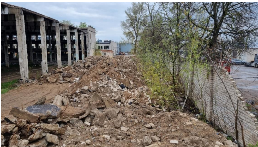
2 pav. Esama situacija, projektuojamos gatvės vietoje
