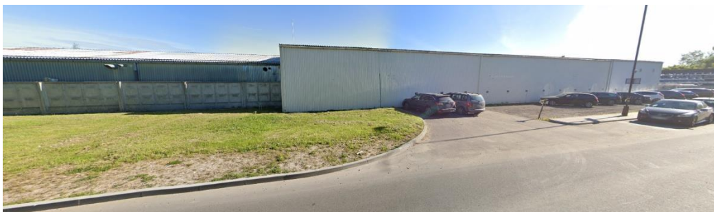
3. Pav. Pietinės sklypo ribos esama užstatymo išklotinė nuo Metalo gatvės
