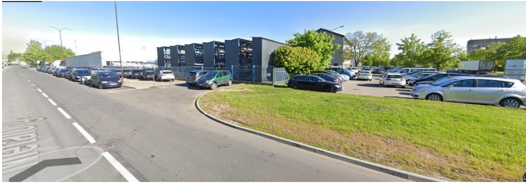
2. Pav. Pietinės sklypo ribos esama užstatymo išklotinė nuo Metalo gatvės.
