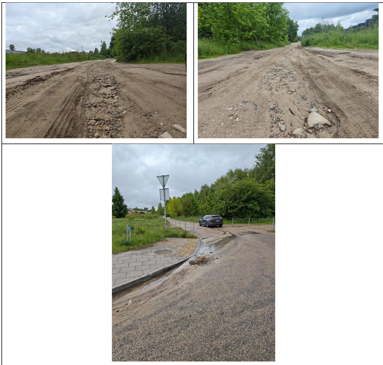
Lentelė 1 Esamos situacijos fotografacija projektuojamos gatvės darbų zonoje
