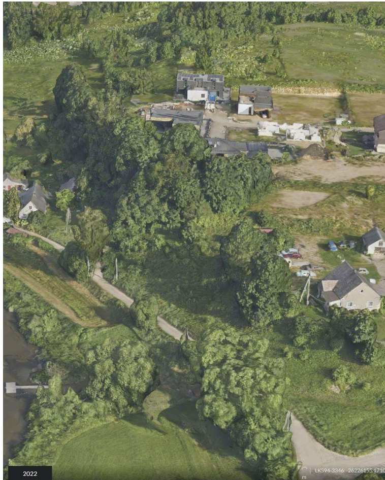
22.4. pav. Esama šlaito 3D situacija šiaurės kryptimi
